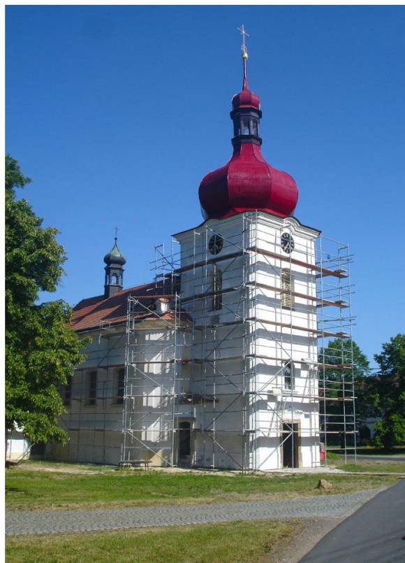
Kostel Nanebevzetí Panny Marie ve Zvíkovci v době rekonstrukce. Snímek ze dne 31. 5. 2023 (foto J. Mikuláš)
